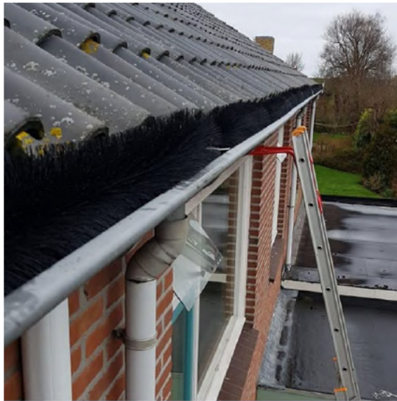
Figuur 5.5 Gebruik van weringsborstels of vulschuim om huismus en vleermuizen te weren onder daken en in kieren en gaten in gevels van woningen (Bron: Unitura)
