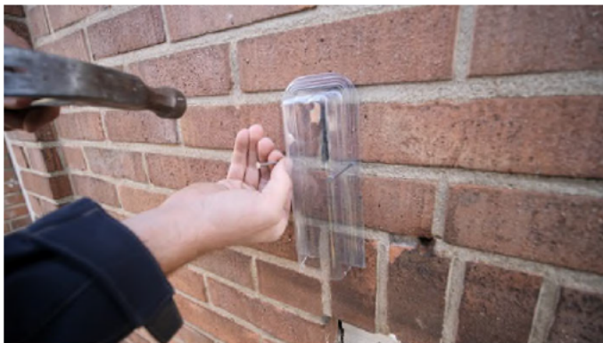
Figuur 5.9 Gebruik van een exclusion flap (EF2 van Unitura) of vulschuim voor het weren van vleermuizen en huismus (Bron: Unitura)
