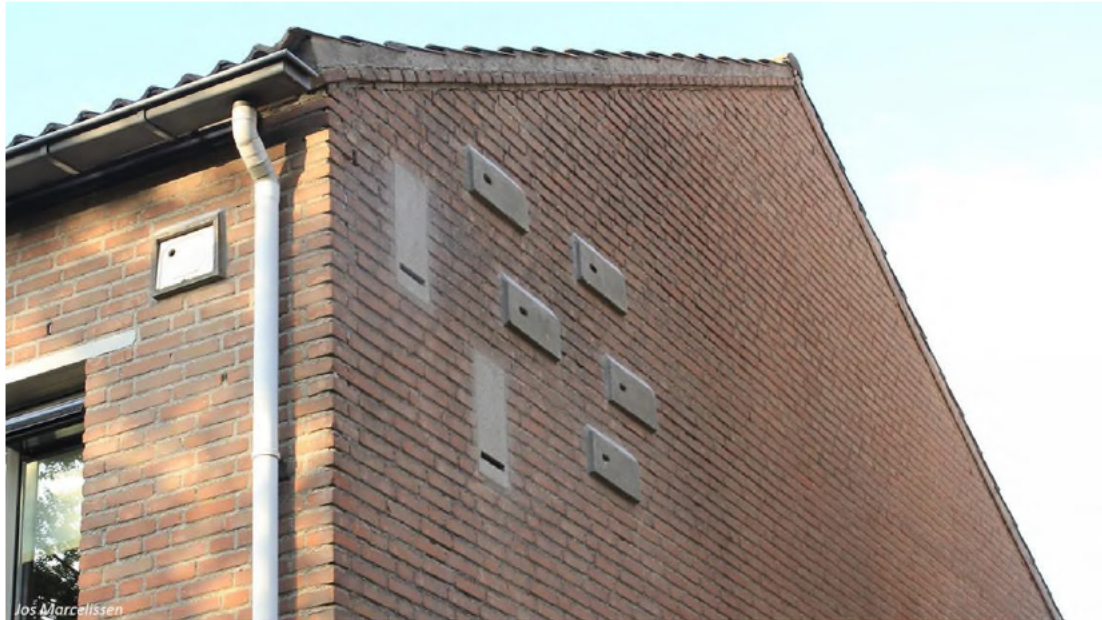
Figuur 5.4 Ingebouwde permanente nestplaatsen voor huismuis van Unitura (links) en Vivara Pro (rechts). Deze kasten kunnen met meerdere tegelijk in een muur worden ingebouwd. Soms worden ze in combinatie met andere kasten (zoals hierboven met 2 vleermuis- en 5 gierzwaluwkasten) in 1 muur geplaatst (Bron: Zoogdiervereniging)
