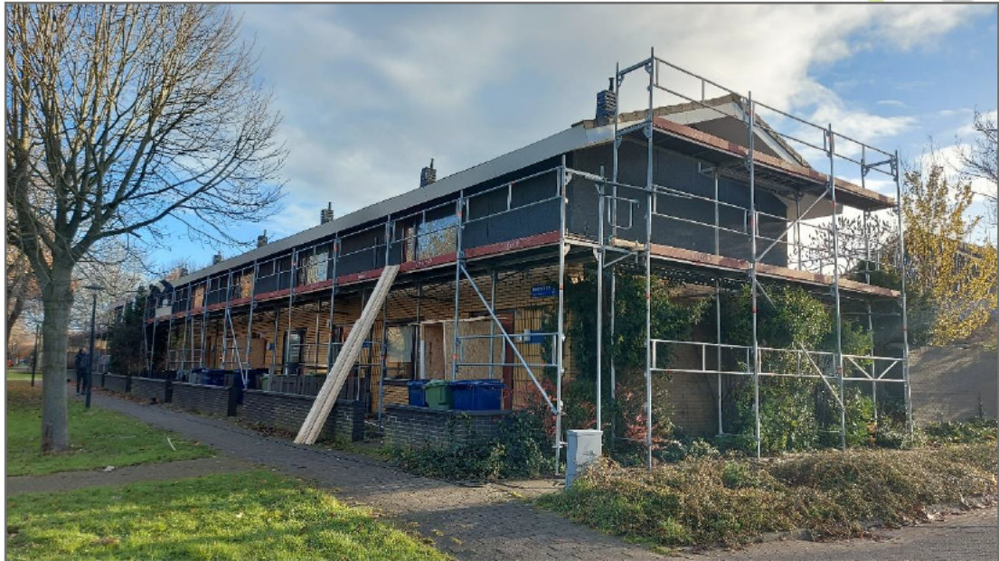
Ten tijde van het verkennend veldonderzoek stond het meest westelijk complex in de steigers en werd er onderhoud gepleegd aan de dakoverstekken. Foto: [REDACTED] Ecoresult B.V.
