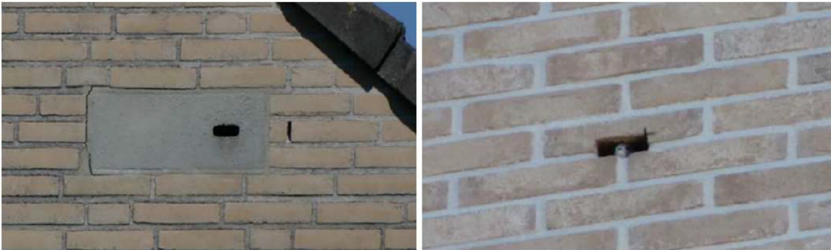
Figuur 5.2: Permanente nestkasten voor de gierwaluw, zichtbaar ingemetseld en onzichtbaar ingemetseld. (BIJ12, 2023)
