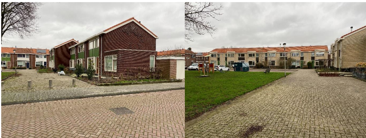
Afbeelding 5. Woningen aan de Ankerstraat (links) en het Vooronder (rechts) in Dronten.
