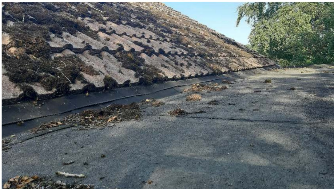
Afbeelding 7: Ruimte onder de dakpannen vanaf de aanbouw.
