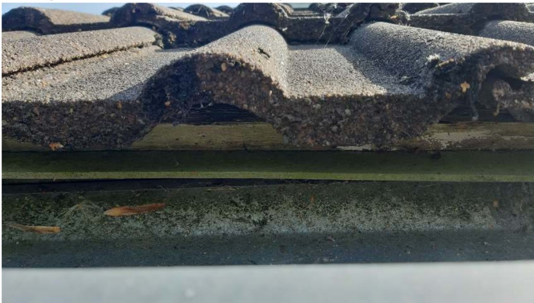
Afbeelding 6: Ruimte onder de dakpannen vanuit de dakgoot.
