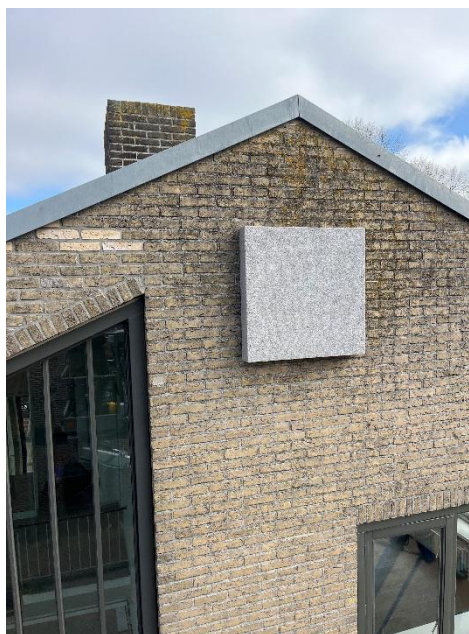
Figuur 6: de kast aan de zuidgevel
