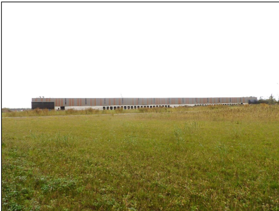
Figuur 11: Ten zuiden van het plangebied staan distributiecentra. Deze hebben geen geschikte openingen voor vleermuizen om een verblijfplaats in te hebben.
