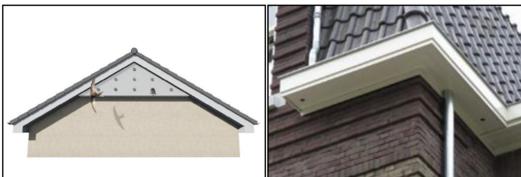
Figuur 6: Gevelbetimmering (links, bron Unitura) en nestgelegenheid in overstek (rechts, bron: Checklist Groen Bouwen).
