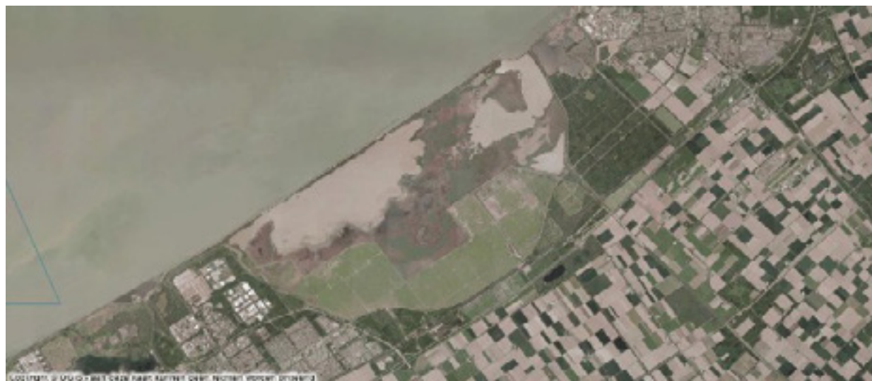
Figuur 5.1 Kaart met de locaties van de geplaatste vispassages met witte pijltjes, en blauw omljnd de zone met natte graslanden, met (1) de vispasseerbare stuw geplaatst in 2019, (2) DeWitt passage tussen droge graslanden en natte graslanden die in 2024 wordt afgerond en (3) de vistrap die de Lage Vaart met de Kitstocht verbindt uit 2023.
