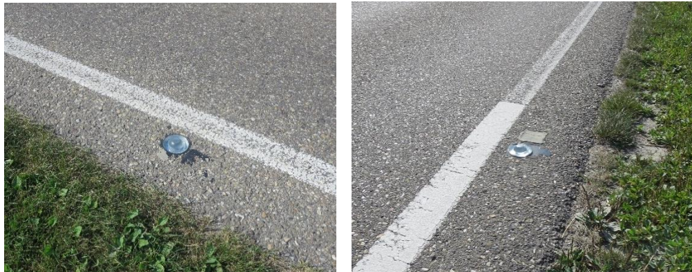
Afbeelding 11: Glasbollen dienen als wegdekreflectoren.
