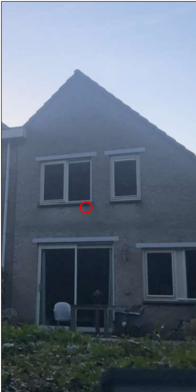
Figuur 4.5 Invliegopening in stootvoeg (rood omcirkeld).
