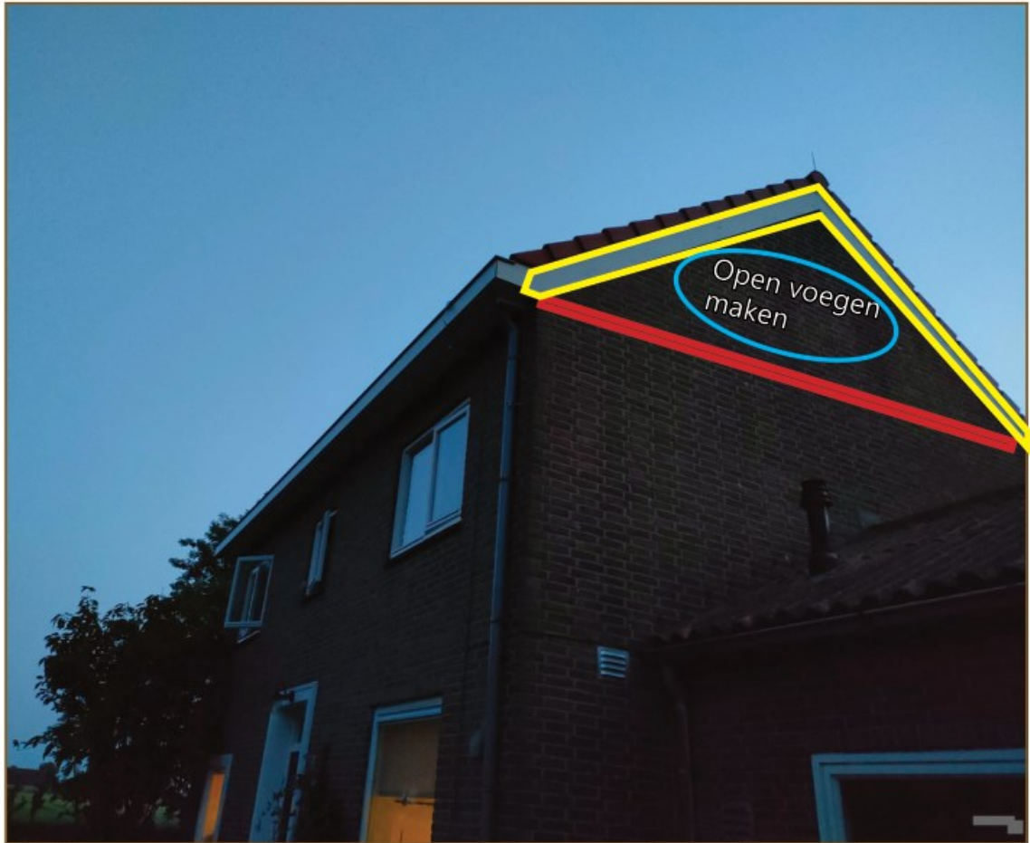
Afbeelding: woning Noordermeerweg 55. Rood = locatie borstels zodat de ruimte erboven niet wordt opgevuld met isolatiemateriaal
