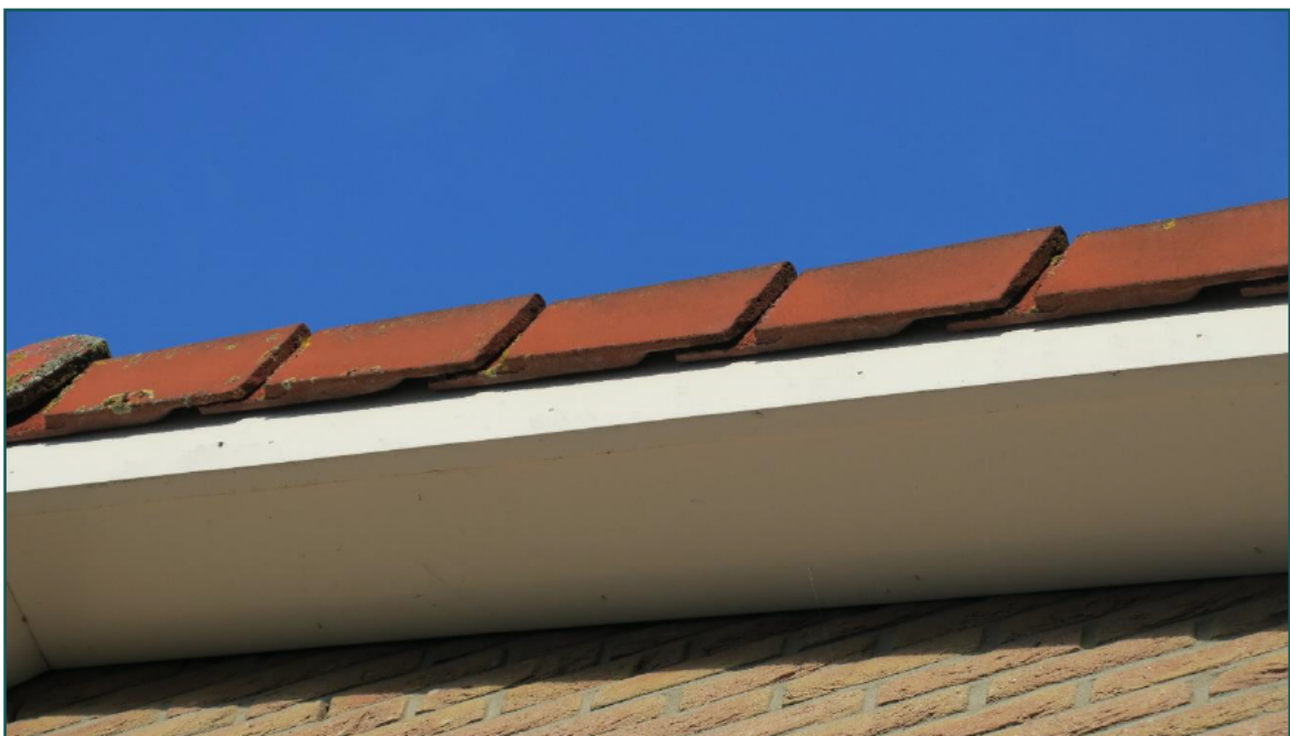
Figuur 3.3 Impressie van de nauwsluitende kantpannen op de planlocatie.
