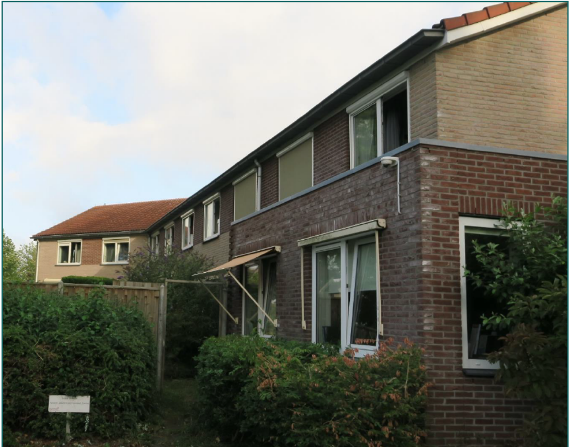
Figuur 1.3 Op de planlocatie is men voornemens om het woonzorggebouw te slopen ten behoeve van een nieuwbouw woonzorggebouw, en een Douglas spar te kappen.
