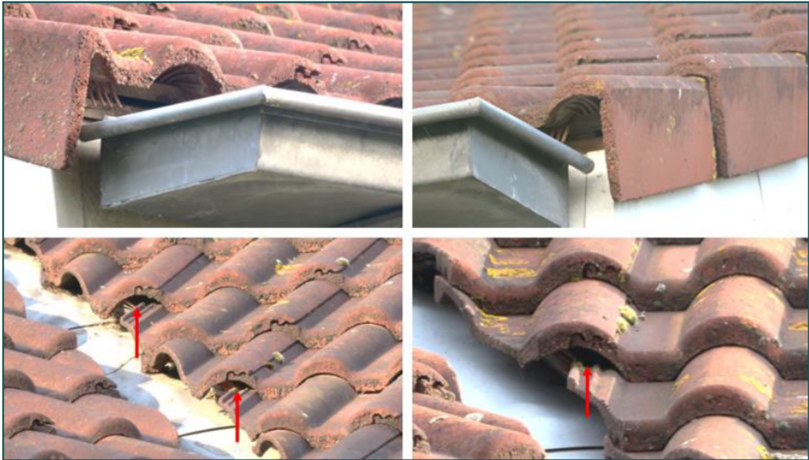
Figuur 3.2 Impressie van de vogelschroten in de te slopen bebouwing. Onder is een impressie van de kierende vogelschroten zichtbaar.
