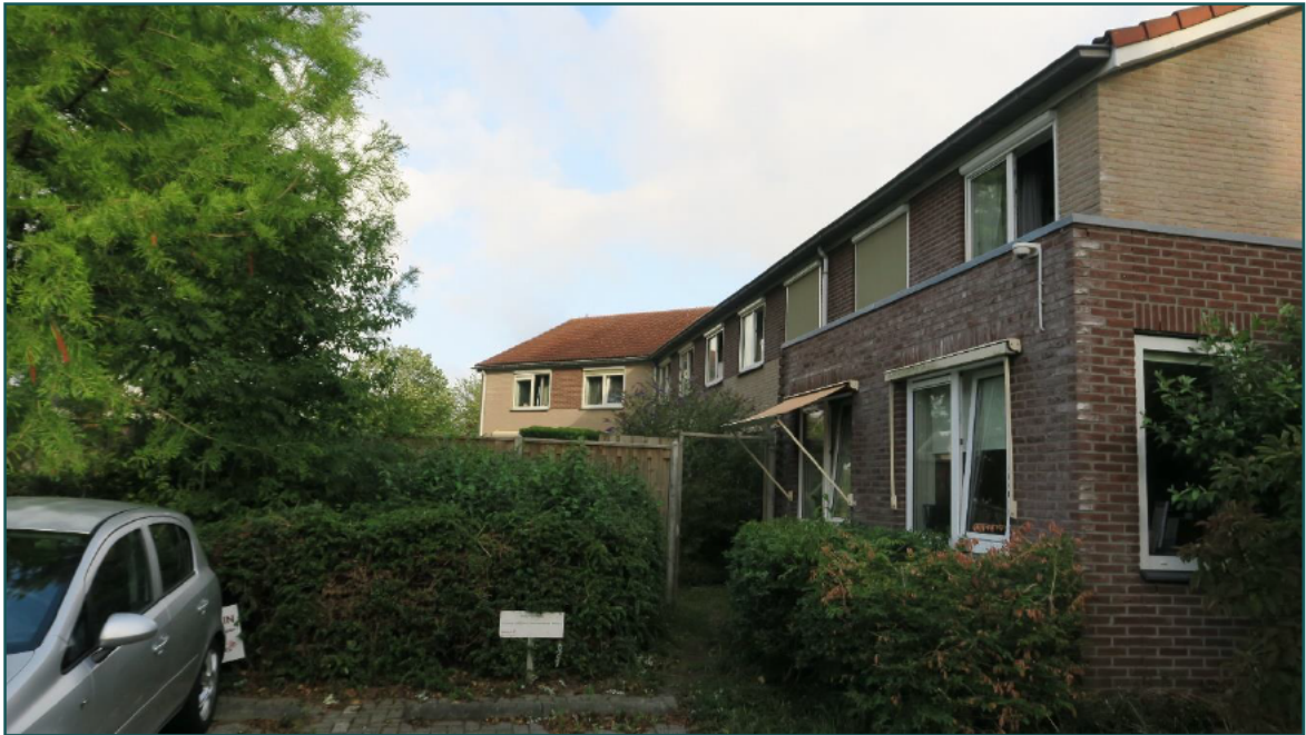
Figuur 1 De planlocatie is gelegen aan de Grevelingenstraat 145 te Lelystad en bestaat uit een woonzorggebouw. De beoogde ruimtelijke ingreep betreft de sloop en nieuwbouw van het woonzorggebouw en de kap van een Douglas spar
