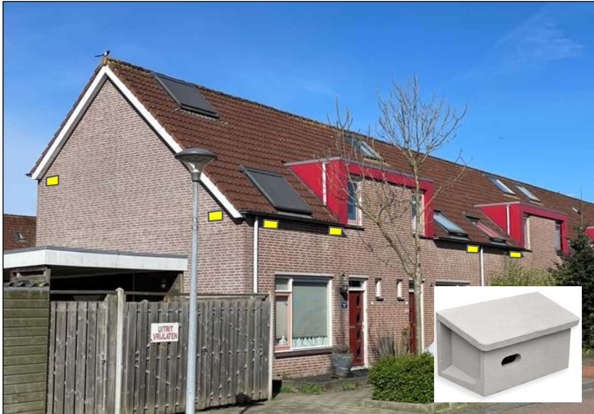
Figuur 28. Geschikte locaties voor opbouw neststenen. Op de kopgevels nabij de dakgoten. Hier niet bovenin of halverwege, omdat de opbouwkasten een belemmering kunnen vormen voor de vrije uitvliegruimte onder de dakpannen. Aan de voorgevel, onder de dakrand hebben de kasten schaduw, waardoor ze niet te heet worden. Kasten niet op de muur ter plaatse van de dakkapellen plaatsen. Minimaal 1 meter tussen de kasten houden, op minimaal 3 meter hoogte.
