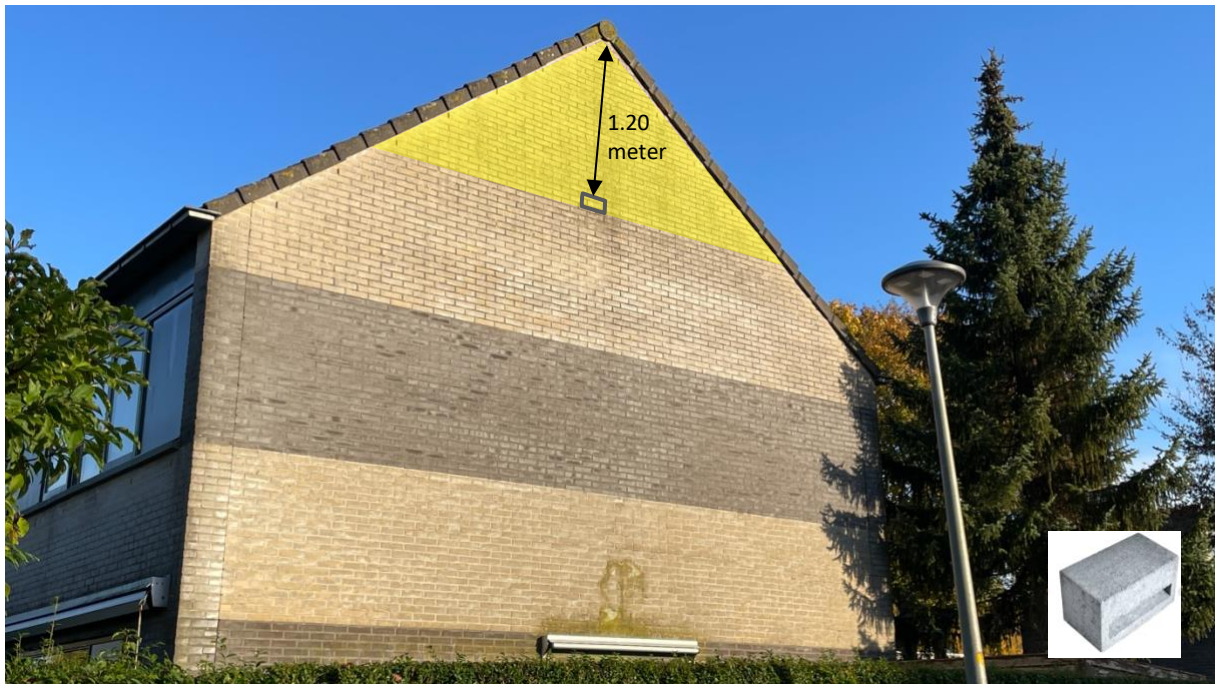
Figuur 31. Bovenste deel spouw van de twee vrijstaande gevels aan de Grote Haag worden niet geïsoleerd. Deze blijven geschikt en toegankelijk voor vleermuizen. Er wordt een entreesteen voor vleermuizen geplaatst.
