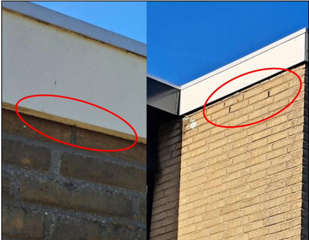
Figuur 4.1: kieren onder de boeidelen en stootvoegen waar zich potentiële verblijfplaatsen voor vleermuizen kunnen bevinden. Bron: Ecogroen.
