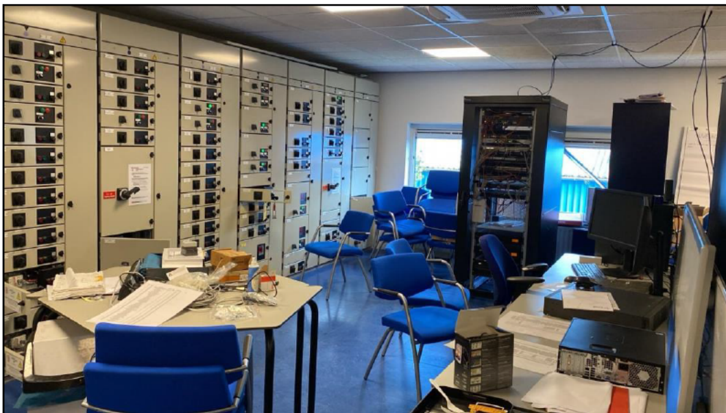
Figuur 2: Impressie van de bedieningsruimte.
