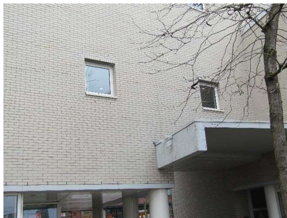
Figuur 3.5: Ramen en muur met open stootvoegen.
