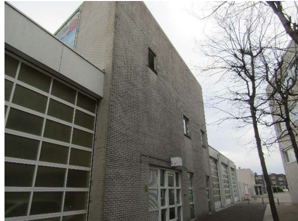
Figuur 3.9: Overzicht werf westgevel.
