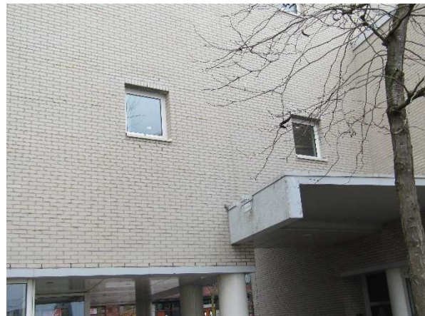
Figuur 3.5: Ramen en muur met open stootvoegen.
