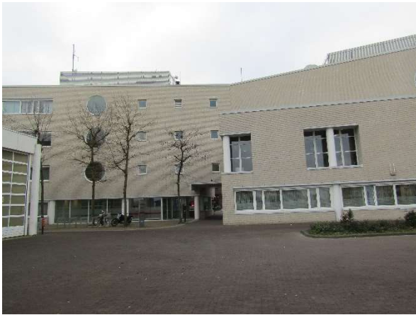
Figuur 3.2: Overzicht gemeentehuis oostgevel.
