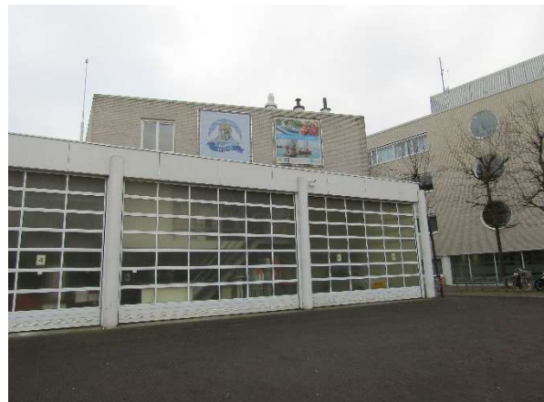
Figuur 3.7: Overzicht werf noordgevel.
