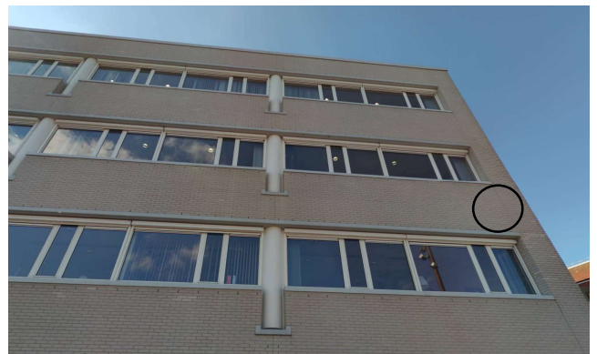
Figuur 4.2: Zomerverblijfplaats gewone dwergvleermuis aan de oostzijde van het pand, Raadhuisplein 1.
