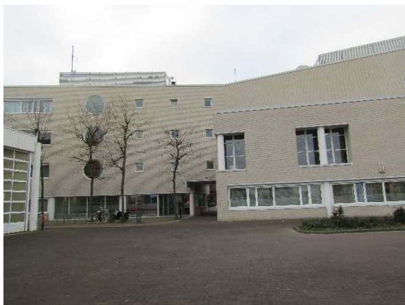
Figuur 3.2: Overzicht gemeentehuis oostgevel.
