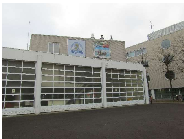
Figuur 3.7: Overzicht werf noordgevel.
