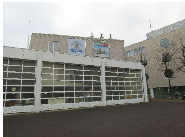
Figuur 3.7: Overzicht werf noordgevel.
