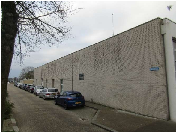
Figuur 3.8: Overzicht werf oostgevel.
