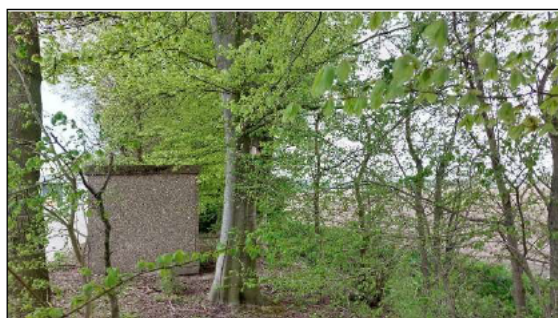
Afbeelding 2.12. Transformatorhuisje in bosschage
