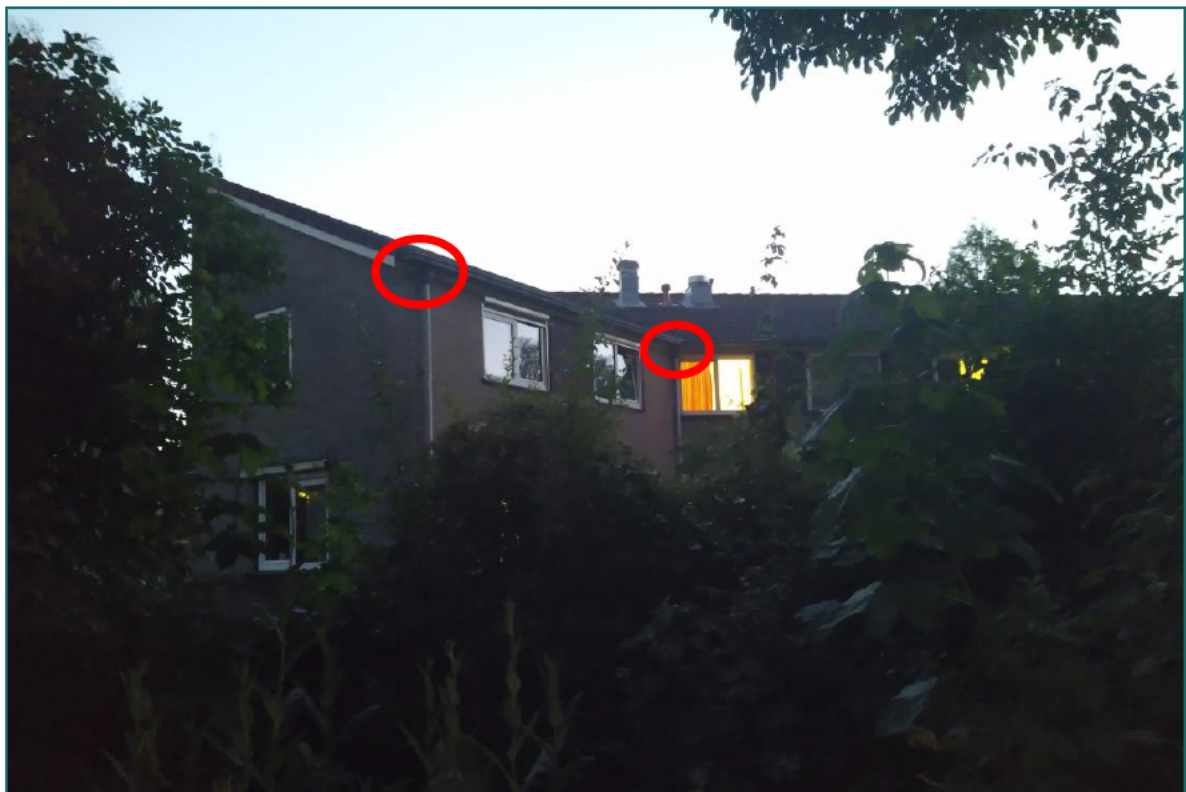
Figuur 3.4 Foto van de vleermuisverblijfplaats aan de Grevelingenstraat 145 zuidkant.
