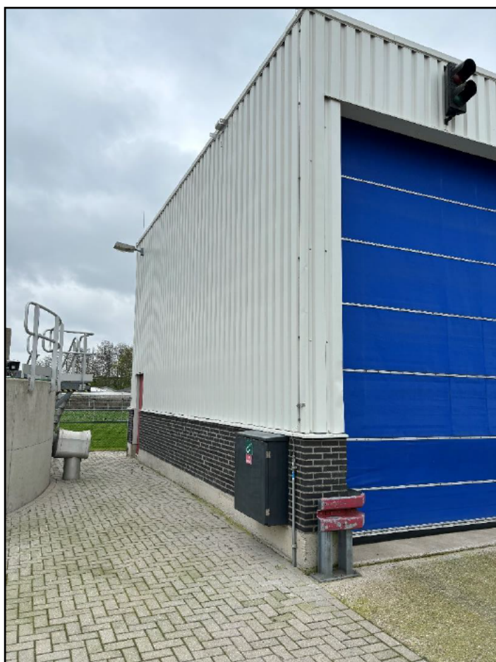
Figuur 9: Overzichtsfoto van de loods.
