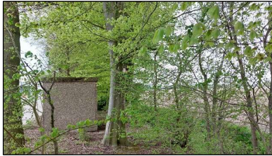
Afbeelding 1.12. Transformatorhuisje in bosschage
