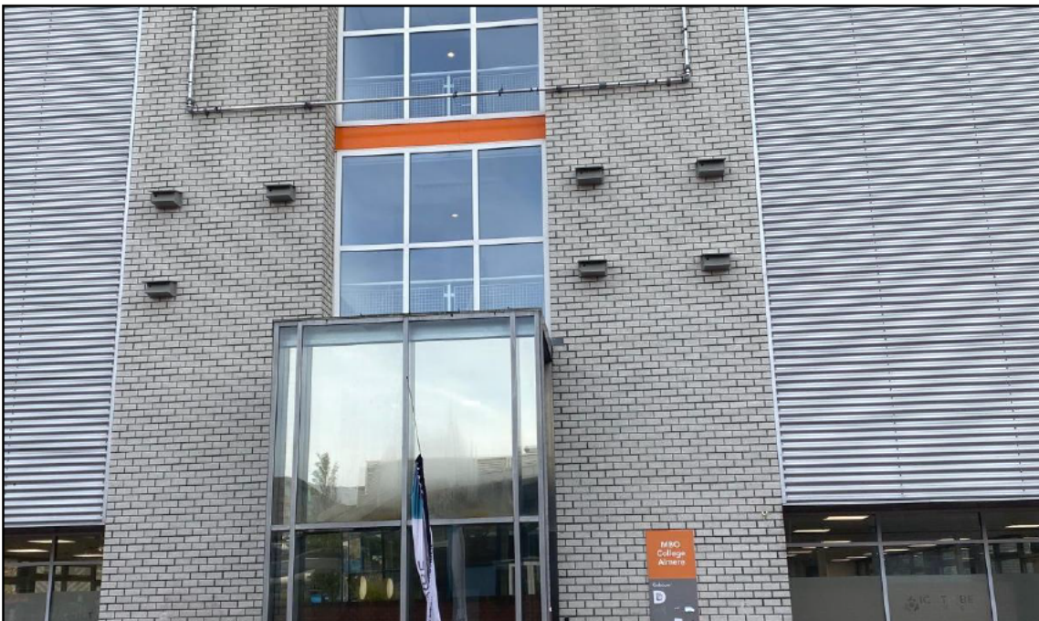
Figuur 16: Zeven nestkasten voor de huismus aan de noordwestelijke gevel van gebouwdeel D.
