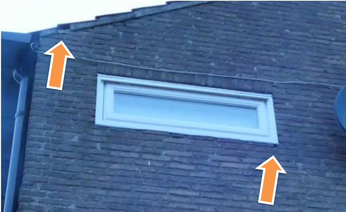
Figuur 4.2 Ruimte bij kantpan waar specie mist, geschikt voor gierzwaluw en vleermuis en openingen rondom raamkozijn.
