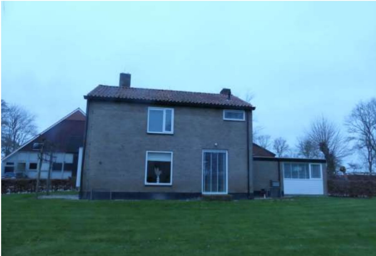
Figuur 1.3 Achterzijde van de woning aan de Zuidwesttering 15 te Nagele.
