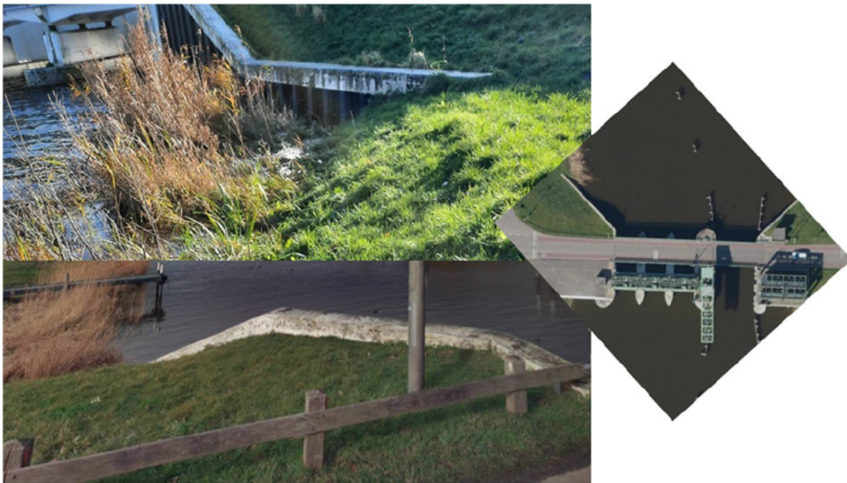
Figuur 2.2 Boven de damwand gezien vanaf de westzijde, onder vanaf de brug en rechts een overzicht vanaf boven(bron streetsmart)
