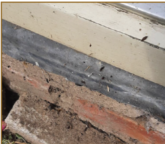
Afb. 1.7: Vleermuiskeutels onder de oostelijke kopgevel van de woning.
