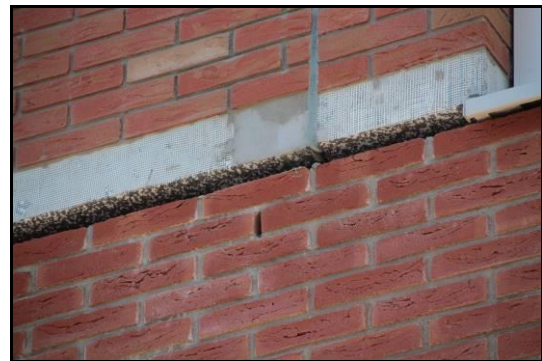
Afbeelding 3: Openingen stootvoegen en dilataties
