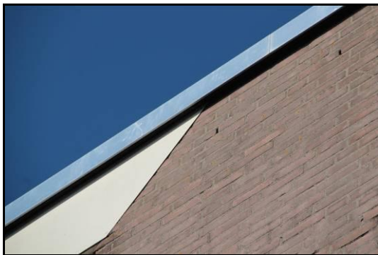
Afbeelding 2: Openingen stootvoegen, gevelbetimmering en dakrand
