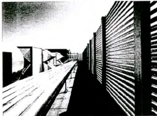
schil rondom installaties
