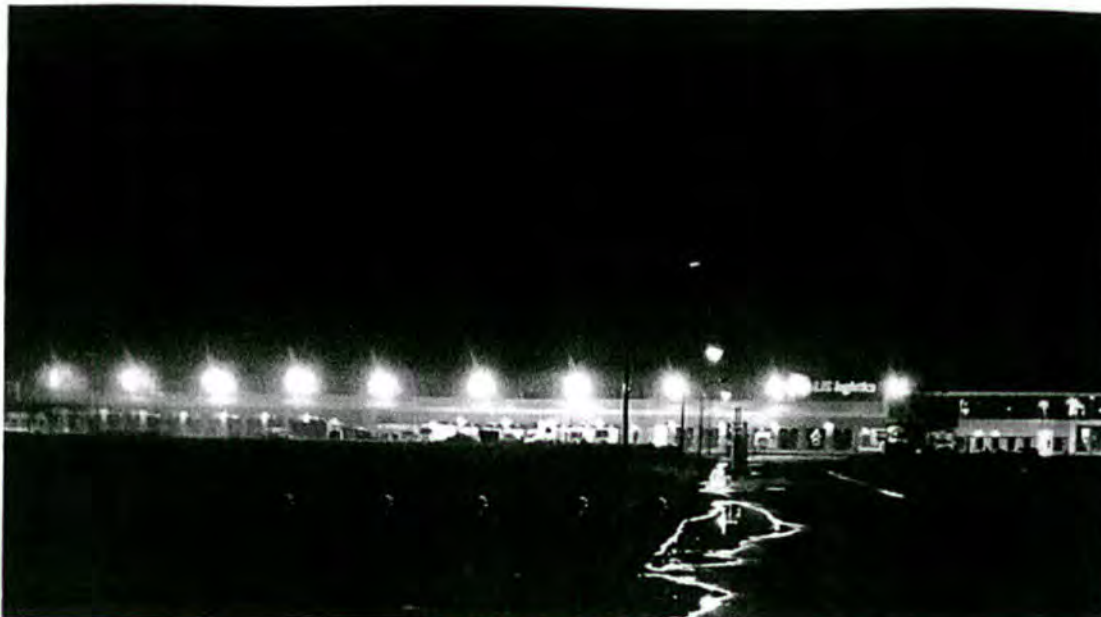
8) Foto van de Noordgevel LIS logistics (zaterdag 13 november 2021 21:00)
