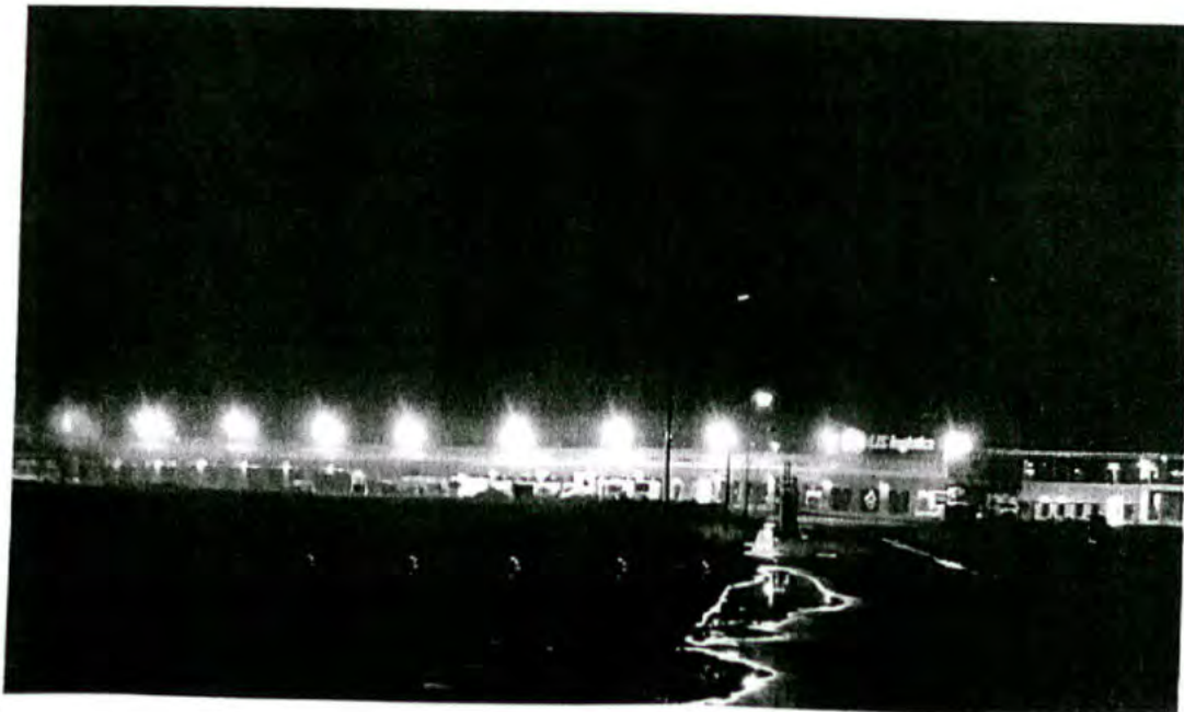
8) Foto van de Noordgevel LIS logistics (zaterdag 13 november 21:00)
