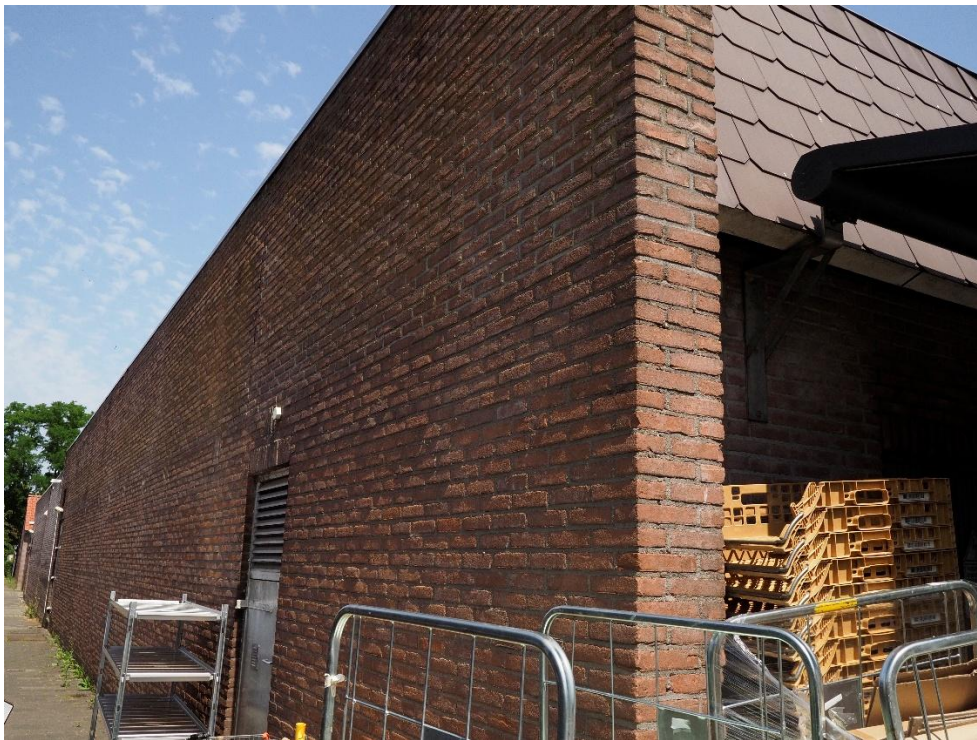
Figuur 5: de steeg aan de westkant, van oa deze gevel zal de buitenschil worden verwijderd, dan geïsoleerd, en afgewerkt met steen strips
