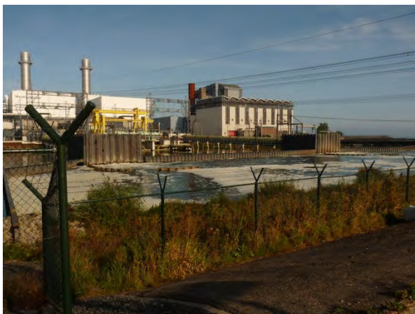
Afbeelding 2.12: Maximacentrale ter plaatse van waterlozing.
