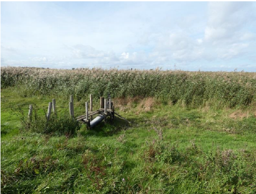
Foto 2. Overlaat bij het drooggevallel deel en nieuwe rietzone. Het water kan over een paar jaar weer opgezet worden tot de hoogte van de buis en dan komt het nieuwe riet in 40 cm diep water staan. Dat kan resulteren in leefgebied voor grote karekiet als het mozaïek-riet wordt.
