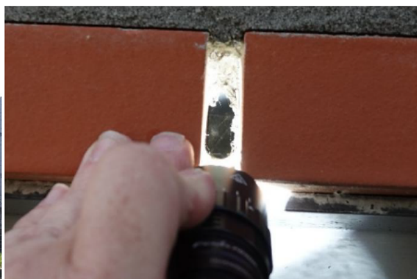
Stadspark 10 – 75: Bouwjaar 1999, gebouwhoogte 21 m, met diverse toegankelijke open stootvoegen, een groot oppervlak en dicht bij het Maerlanthuis. Bij de inspectie van de open stootvoegen onder in het gebouw is geen isolatiemateriaal aangetroffen, maar van dit pand zijn niet alle open stootvoegen breed genoeg om ook vleermuizen toe te laten. Een deel van de open stootvoegen is wel toegankelijk en in de open stootvoegen is geen isolatiemateriaal aangetroffen.
