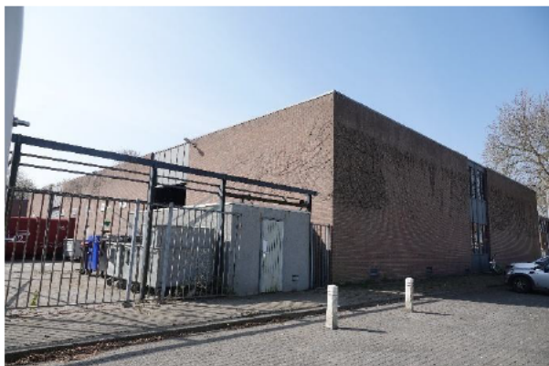
Schroefstraat 2: Bouwjaar 1978, gebouwhoogte 7 meter, energielabel B, geen isolatiemateriaal in luchtspouw aangetroffen, groot pand met rondom dakrand aan alle zijden toegankelijke open stootvoegen.
