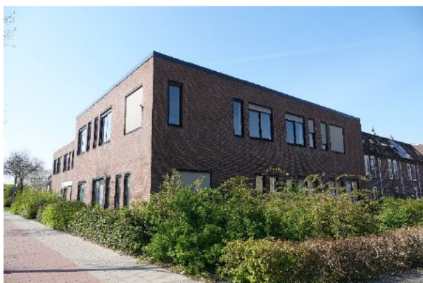
De Stelling 13 – 1: Bouwjaar 1977, gebouwhoogte 7 m, energielabel C, veel open stootvoegen, een ruim oppervlak aan luchtspouw waarin wel glaswol/steenwol is aangetroffen, maar deze niet de volledige ruimte vult (zie ook massawinterverblijven aan de Meenthoek 7 en Binnendijk 95).
