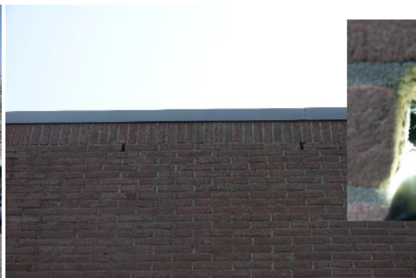
Schroefstraat 2: Bouwjaar 1978, gebouwhoogte 7 meter, energielabel B, geen isolatiemateriaal in luchtspouw aangetroffen, groot pand met rondom dakrand aan alle zijden toegankelijke open stootvoegen.
